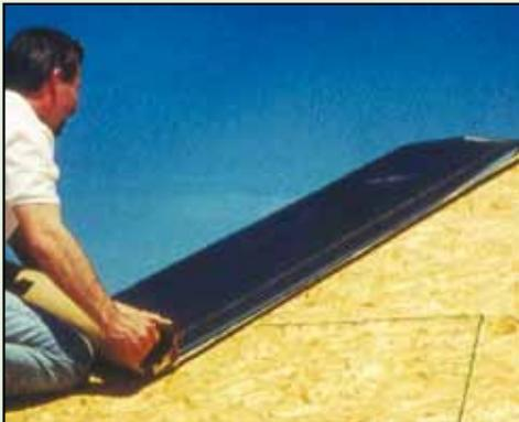
**Figura 14.** La membrana sintética normalmente está hecha de polipropileno, poliéster o tela de fibra de vidrio que pesa menos que la membrana asfáltica y soporta la exposición a condiciones climáticas variables. Fuente: Carlisle Coatings & Waterproofing.
