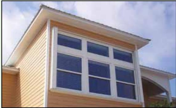
**Figura 17.** Persianas de acordeón (ilustradas en posición abierta) instaladas en un grupo importante de ventanas de una vivienda ubicada en la zona costera. Las persianas se instalaron de modo tal que pueden operarse desde el interior del hogar. Fuente: Roll-a-way/QMI.
