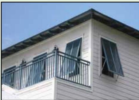
**Figura 18.** Las persianas hechas de componentes duraderos de aluminio extruido añaden un sabor “isleño” a la casa y ofrecen protección de aberturas efectiva. Fuente: Roll-a-way/QMI
