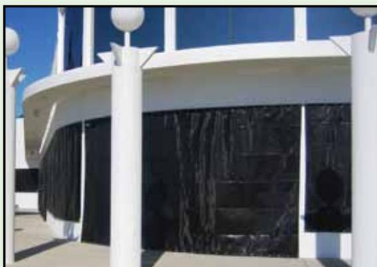
**Figura 24. Protección contra el viento de tela de tejido de esterilla de polietileno desplegada directamente sobre las ventanas de la planta baja de una vivienda en la zona costera. Fuente: Roll-a-way/QMI.**
