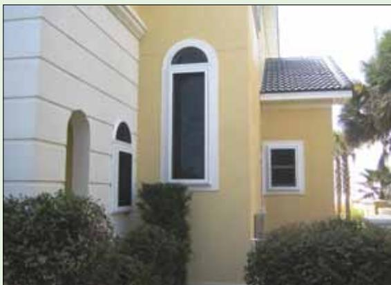
**Figura 22.** Pantallas instaladas de acero inoxidable resistentes a impactos protegen varias ventanas de una vivienda ubicada en la zona costera. Este sistema no requiere de despliegue y proporciona sombra.
