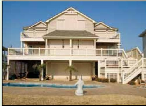
**Figura 16.** Una vivienda en la zona costera protegida con persianas de enrollar en todas sus ventanas y puertas. La persiana se mantiene en su lugar mediante rieles verticales y puede operarse manualmente o con un motor eléctrico integrado. Fuente: Roll-a-way/QMI.
