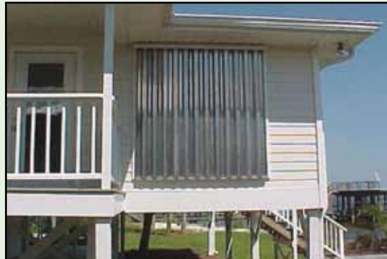
**Figura 21.** Estos paneles anti tormenta de aluminio de calibre 0.050 ofrecen una protección económica contra las tormentas. En este ejemplo, los paneles se insertan en una guía sobre la ventana y se sujetan a una guía inferior mediante tuercas de mariposa. Fuente: Roll-a-way/QMI.
