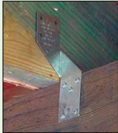
**Figura 13.** Una fijación para huracanes instalada durante la construcción de una nueva vivienda. Se requiere una fijación para huracanes para cada armadura-viga que no esté a la vista al finalizar la estructura.
