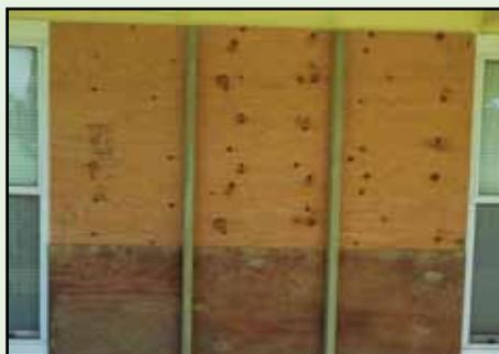
**Figura 28.** Para las ventanas más grandes, como esta puerta de vidrio corrediza, se colocan dos tirantes de 2 por 4 pulgadas del lado de afuera y se orientan con el extremo angosto contra la madera terciada. La madera terciada se sujeta a los tirantes de 2 por 4 pulgadas mediante tornillos de fijación.
